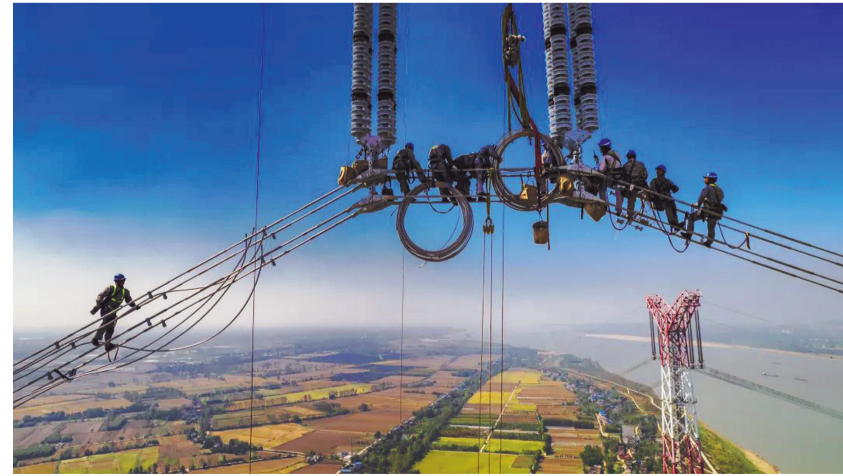
2022年10月12日,安徽池州长江大跨越工程建设正在进行中。该工程跨江钢管塔高345米,跨越江面距离2354米。 跨越“牵手” 芮月生摄
