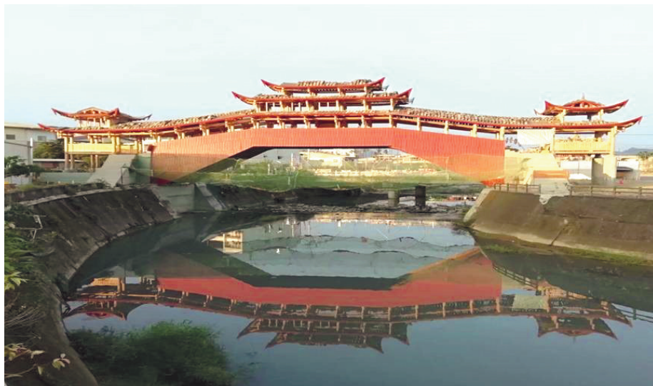
中国台湾“浙江泰顺廊桥”。2019年,曾家快赴宝岛台湾南投县集集镇建成这座廊桥,目前为台湾地区唯一的木拱廊桥。该桥长43.5米,木拱跨度28米,桥宽5.5米,采用三重檐结构,两端桥头设亭,离水面高度20米。(吴俊星 摄)
