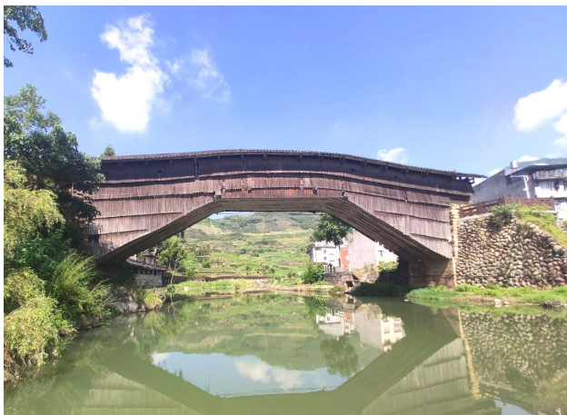
泰顺三条桥(修复)。2021年,胡森修复第六批全国重点文物保护单位泰顺三条桥。该桥位于温州市泰顺县洲岭乡和洋溪乡交界溪上,建于宋绍兴七年(1137年)九月十三日,重建于清道光二十三年(1843年),为叠梁式木拱廊桥。长26.63米,宽4米,离水面高10米,建桥屋11间,明间五架柱梁,柱头有蝶形莲花瓣头拱榫。(吴俊星 摄)
