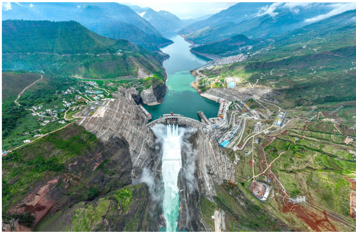
白鹤滩水电站
