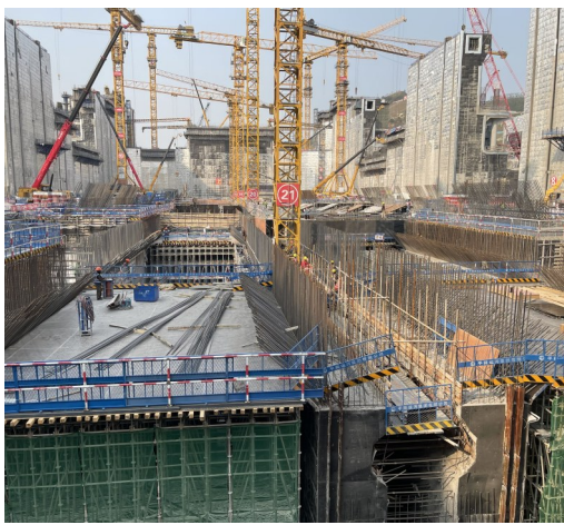
平陆运河马道枢纽施工现场
